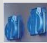
Tomacorrientes a prueba de agua del lado lateral derecho dentro de la cabina, con el fin de conectar pequeños equipos en su interior.
