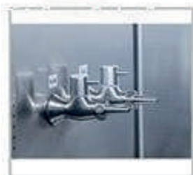
Grifos de agua y gas
